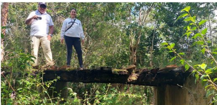
FIGURA N°02: TRAMO CRÍTICO DE LA QUEBRADA LA BANDA, DONDE SE OBSERVA EN MAL ESTADO EL PUENTE PEATONAL DEBIDO A QUE SE ENCUENTRA COLMATADA LA QUEBRADA
