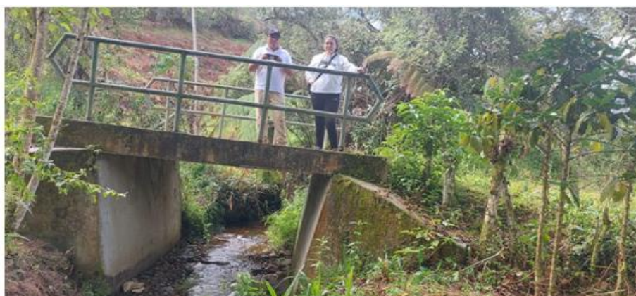
FIGURA N°01: TRAMO CRÍTICO DE LA QUEBRADA LA BANDA, DONDE SE OBSERVA LA EROSION EN LAS PAREDES DEL TALUD DE LA RIBERA.
